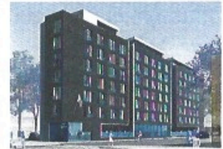
MAMA SHELTER - LYON Rue Damer LYON 7 ème
